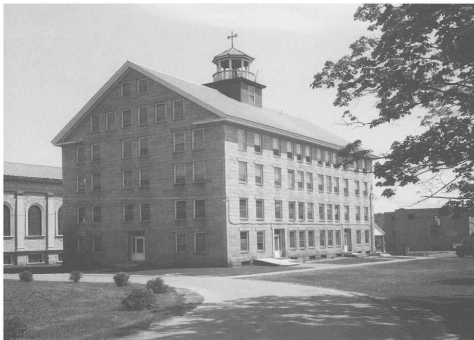
Рис. 4. Большой каменный жилой дом шейкеров в Энфилд, Нью-Гэмпшир, 1837-1841 гг. Купол является более поздней надстройкой. Фотография Э. Р. Пирсона, 1971 г. Источник: The Architecture of Control: Shaker Dwelling Houses and the Reform Movement in Early-Nineteenth-Century America. [Электронный ресурс]. Режим доступа: URL: https://online.ucpress.edu/jsah/article-abstract/62/3/352/59632/The-Architecture-of-Control-Shaker-Dwelling-Houses?redirectedFrom=fulltext (Дата обращения: 29.10.2023).
